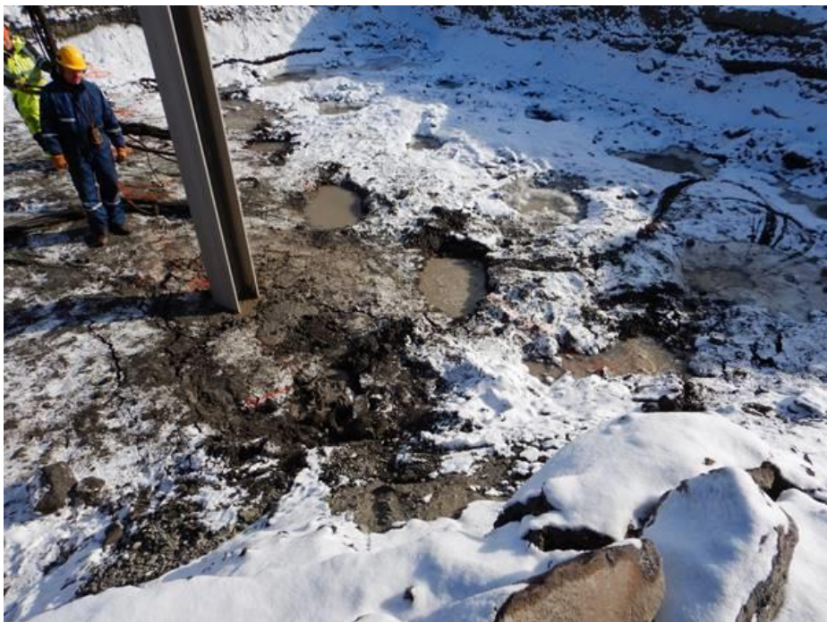
Mynd 11 Djúppjöppun með titurstaur. Nokkrar þjöppunarholur á svæðinu
