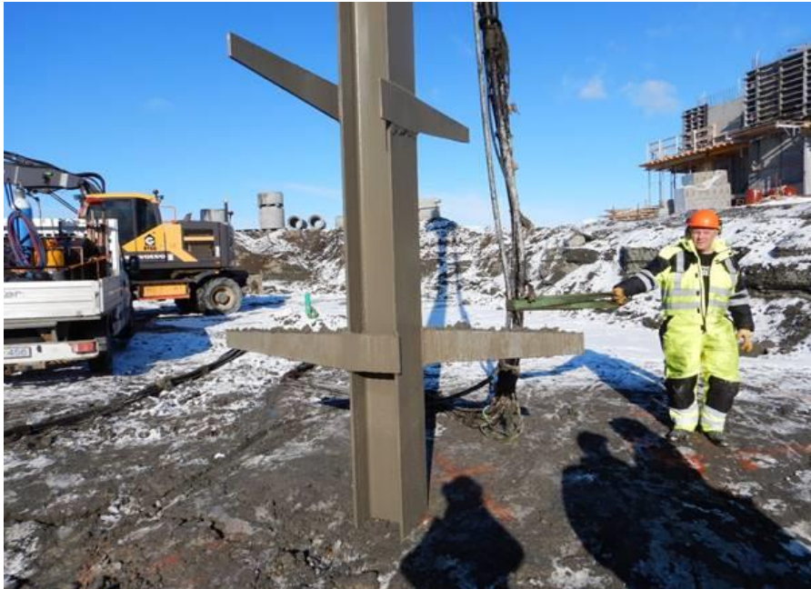
Mynd 10 Djúppjöppun með titurstaur. Hér eru tvö „eyru“, soðin hornrétt á bitann. Hvert eyra er tæpur 1 m á lengd, um 0,25 m breið stálplata við staurinn.
